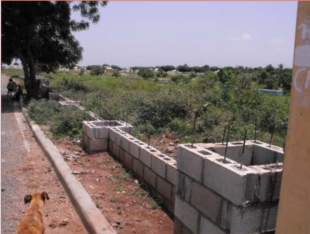
Construcción verja perimetral del cementerio de Barrio Nuevo
