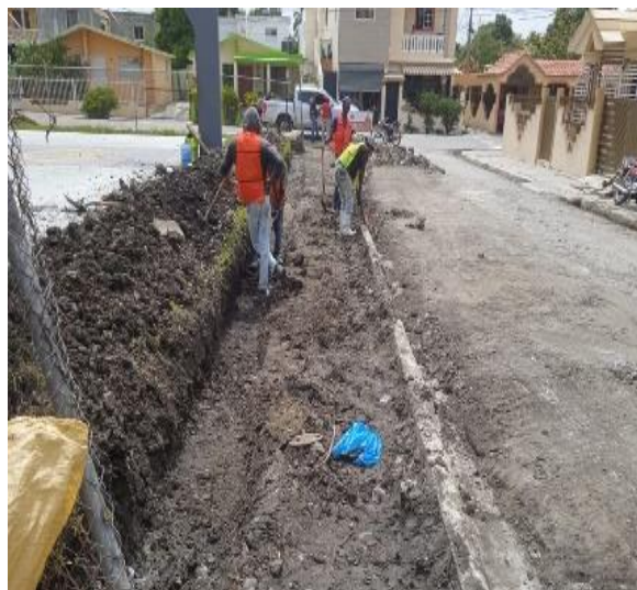
Colocación de Tuberías para acueducto en la comunidad de Mogollón.
