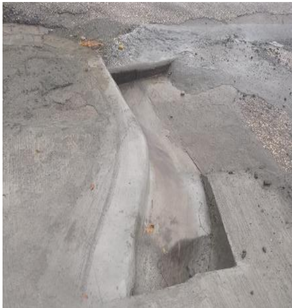
Saneamiento de cañada en barrio Santa Clara
