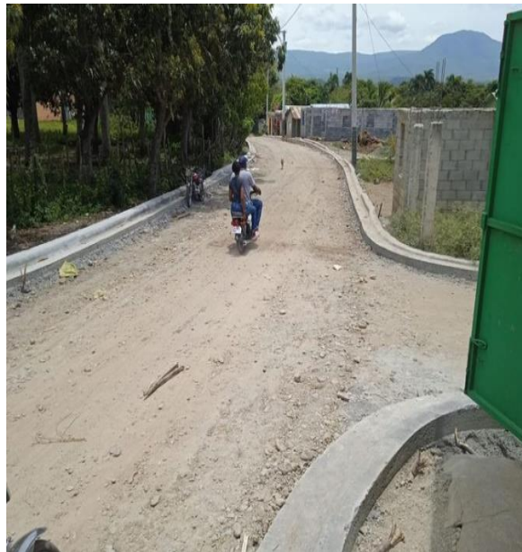
Construcción de contenes en el Hato de la Culata
