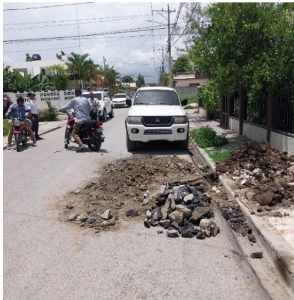
Trabajos para evitar la ocupación de aceras y el retiro de Kioscos y negocios que obstruyen el libre tránsito
